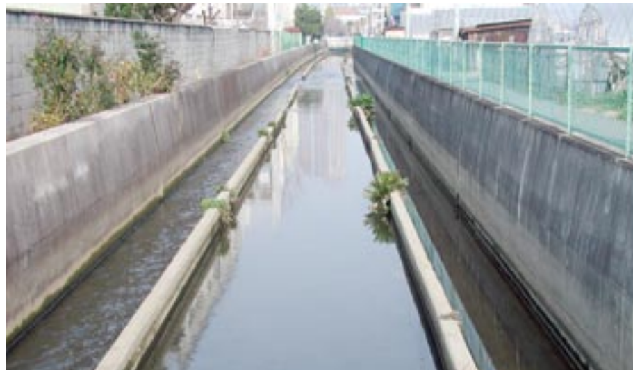
三断面構造の長瀬川（森河内西附近）の写真
