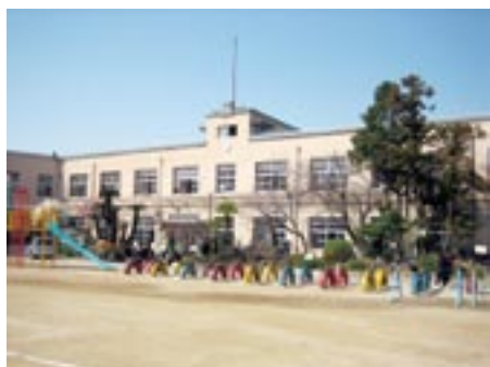
校庭側全景（南面）
