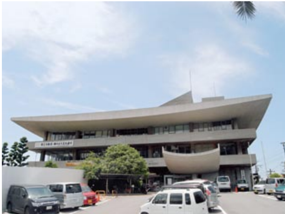
エントランス立面
