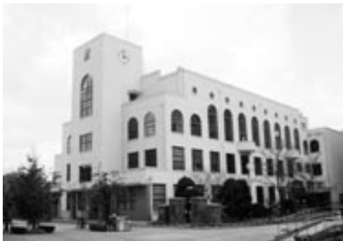
南東面から見る
