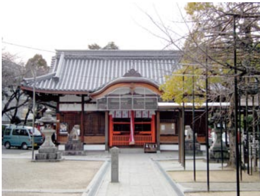
三輪神社社殿（拝殿正面）
