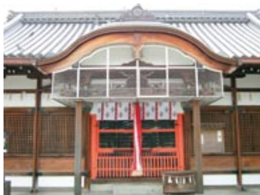
際立つ素木と朱塗りのコントラスト・拝殿正面と唐破風
