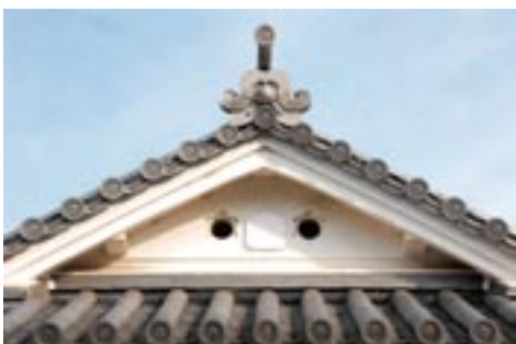
ロボットの顔にも見える正面妻壁の空気抜き穴ほか
