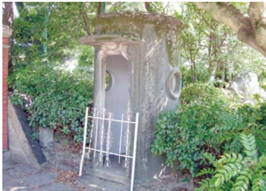
守衛施設全景;ポストにも見えるし、庇が学生帽に似て人頭にも見える
