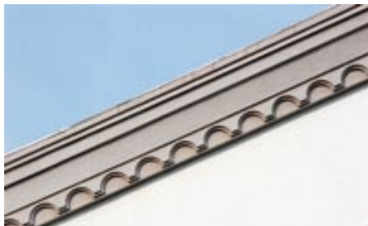
シンプルでリズムカルな破風(レーキングコーニス)の意匠
