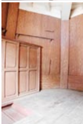
解体工事前の燈台内部 平成15年(2003)堺市教育委員会社会教育課提供
