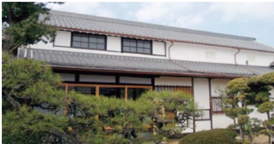
南からの外観（主屋と庭園）
