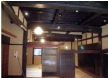
主屋内部（土間部分）
