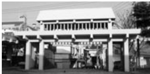
RC造で再建された山門
