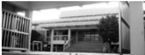
RC造で再建された本堂
