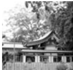
鉄筋コンクリート造で再興された社殿
