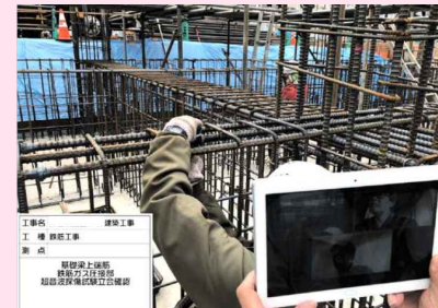
Webカメラを利用した遠隔検査
