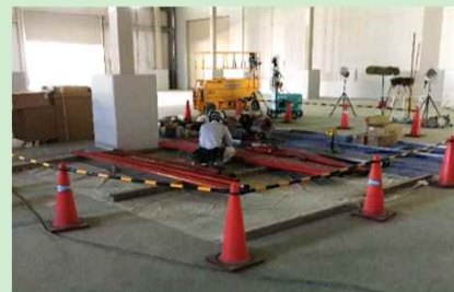
工事エリアの区画を設定して作業
