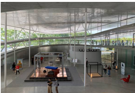
リング状のスラブが取り巻く吹き抜け
