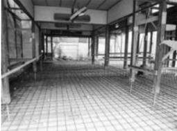
写真1) ベタ基礎打設前の様子
