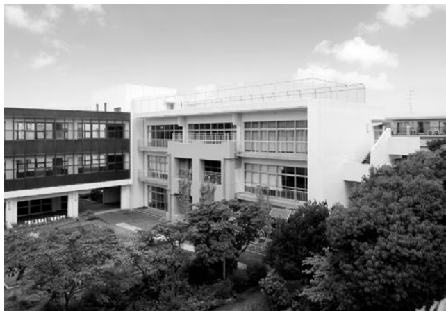
学校園施設耐震補強工事
