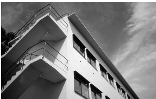
2012 年に改修を施された南寮の外観
