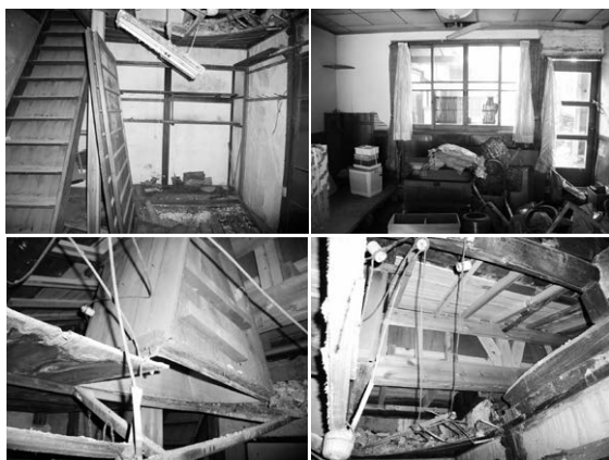
図7 改修前写真 撮影／NEO GEO
