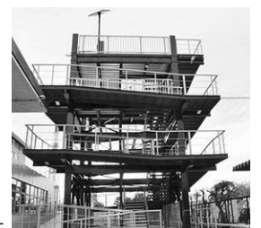
津波避難タワー
