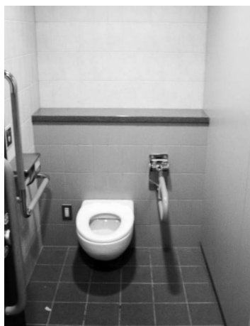
写真1 手動車いすでも利用できる一般トイレの便房
