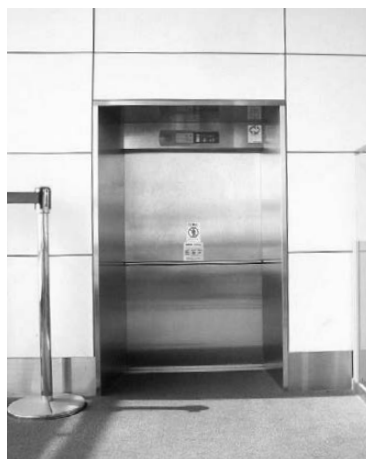
写真2 搭乗ゲート脇の荷物用EV
