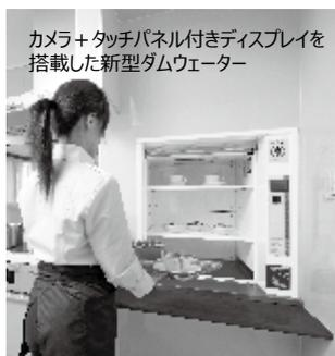
カメラ+タッチパネル付きディスプレイを搭載した新型ダムウエーター
