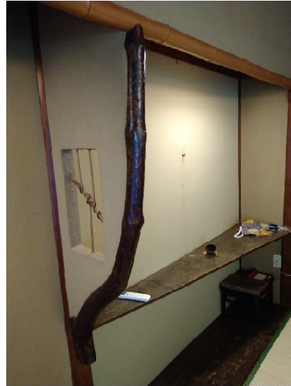
壁床で柱から自然木を出している 飾り窓も自然木が使われています 落とし掛けは竹で施工されています
