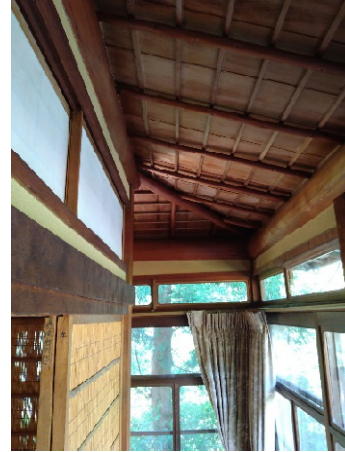
広縁の壁と天井を見る 縁桁と化粧垂木 化粧小舞と天井板 広縁に長押を持つ
