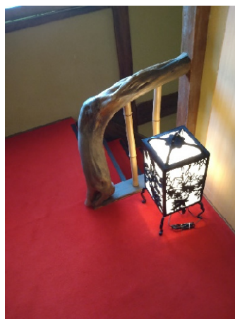
階段部の転落防止柵（変木と竹の組み合わせ）
