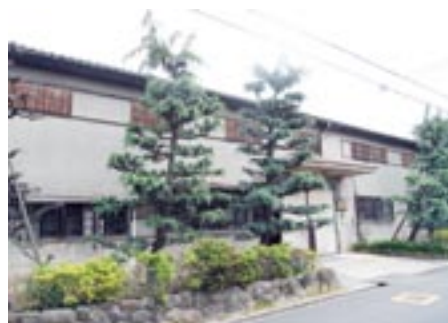
工場入口事務所棟
