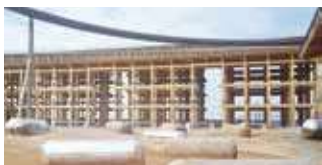
大阪での敷設
