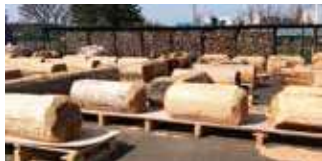
福島での基礎仮組み
