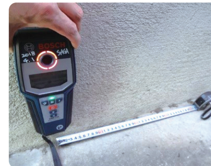
鉄筋調査(鉄筋探査機)
