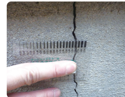
ひび割れ調査(クラックスケール)
