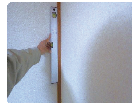
柱の傾き調査(水準器)
