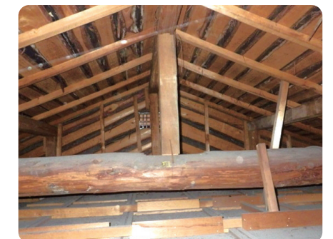
屋根裏調査(点検口から目視)
