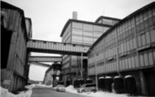
中央通路から見る仕上粉末室棟
