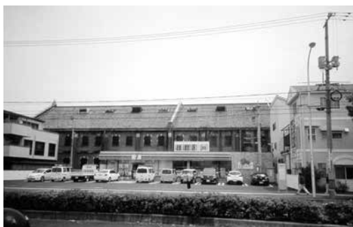
西側の道路から見る外観
