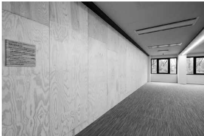
写真2 T-FoRest® Wall でRC造建物を耐震補強・内装木質化した事例 (武庫川女子大学文学2号館教室)
