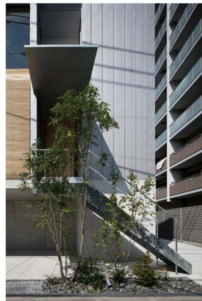
敷地は住宅地に位置し、道路を挟んで旧社屋と倉庫に面しています。施主は林業用資材を取り扱う商社で、旧社屋が手狭となり新しく社屋を建設する事になりました。事業に関連した建築を目指し、木造で自然光に溢れる快適な社屋を提案しました。建物は1階倉庫、2階執務室という構成で、機能優先の外観構成としながら、道路に面したファサードには檜の簾を配して、建築と街を柔らかく繋いでいます。1、2階とも無柱の大きな空間を、6m スパンの門型フレームを0.91m 間隔で連続させて構成し、そのフレームを全て木地表しとしています。執務室の奥に自然光が届くよう、ノコギリ屋根を連続させ、トップサイドライトから光を取り入れています。(井上久実)
