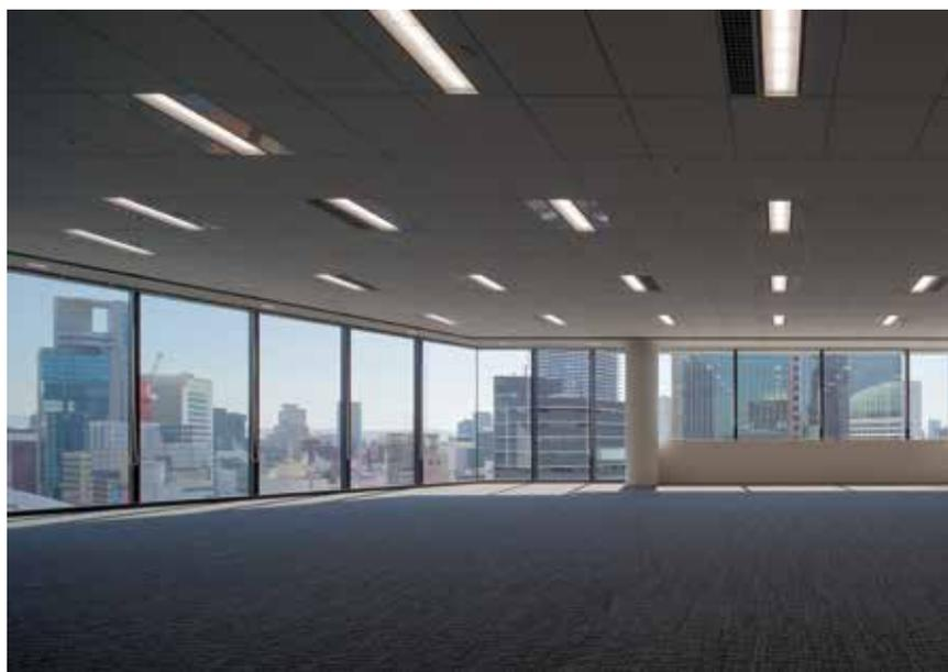
四ツ橋筋と国道2号線に面する桜橋の交差点に立地し、不整形な台形で狭隘な敷地にあっても、周辺のビルに埋もれない競争力の高いテナントオフィスビルを目指した。外観は台形平面の対角を結ぶ緩やかな円弧を描くエッジの効いたスカイラインと、各階スパンドレル部に設けたPC製の三重庇を積層して水平線を強調し、また通りを遠くまで望むことができる立地特性を活かして、交差点角に面するコーナー部はフルハイトサッシュとして、街に開かれた佇まいとした。平面計画は最大限整形なオフィススペースを確保するようL字型に配置し、コアはX階段の採用よりコンパクトにまとめ、基準階でレンタル比77%を実現している。
