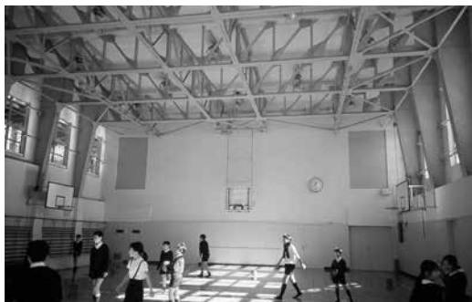
明るい体育館の内部。鉄骨架構が美しい。
