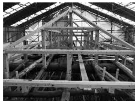
本徳寺・本堂改修工事現場
