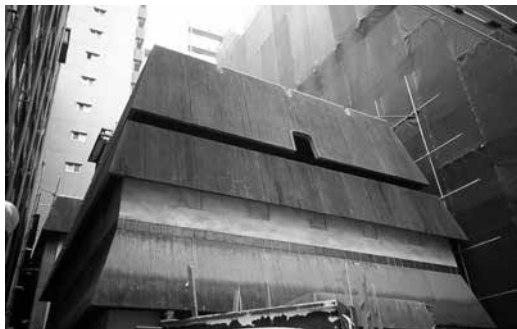
外観の詳細。庇壁表面は縦溝が刻まれている。
