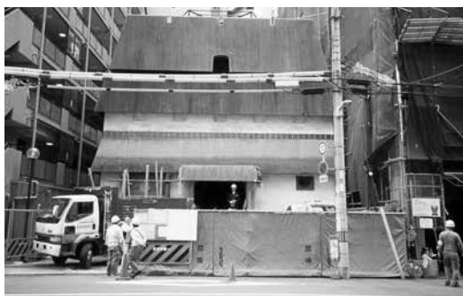
東側の正面外観。均整の取れた立面。
