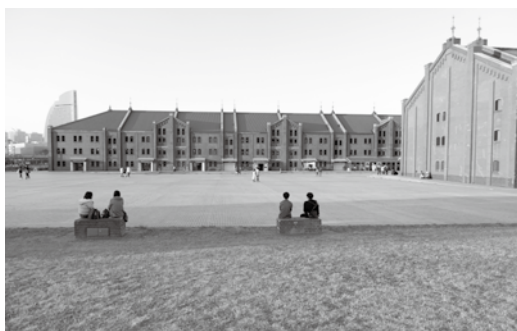
南側から見る赤レンガ倉庫。左側が1号館
