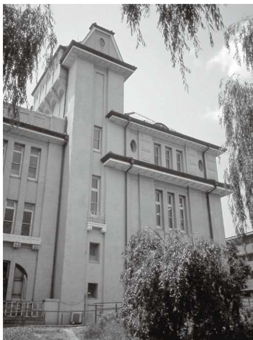
鴨川に面する東側の外観
