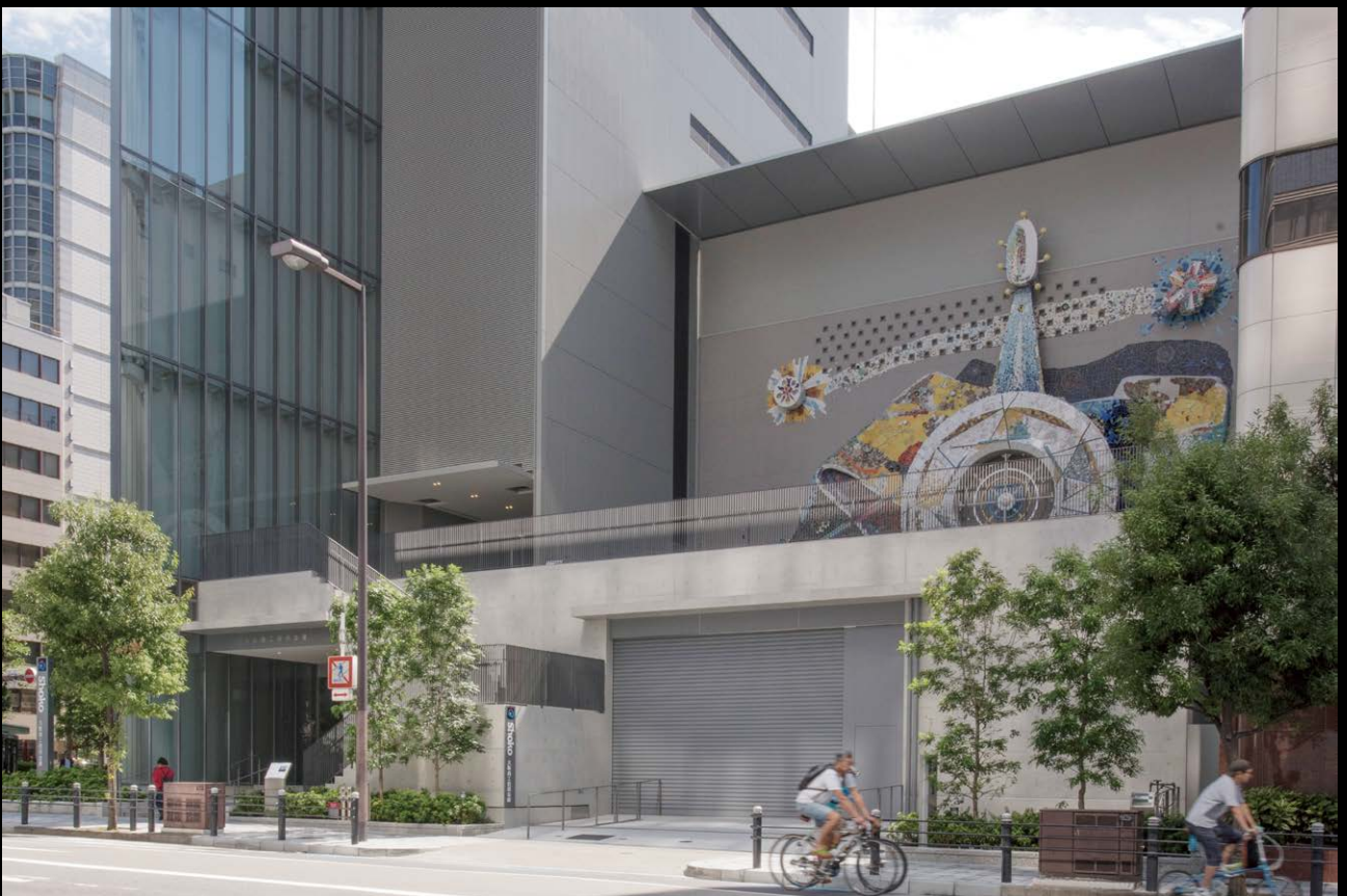
レリーフは復元保存され、2階レベルに設置。歩行者にも開放されている。
