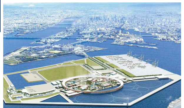
夢洲で開催される2025年大阪・関西万博 (c) Sou Fujimoto Architects
