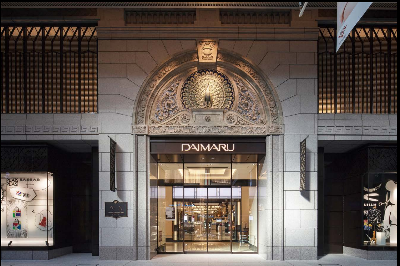
旧本館の象徴「孔雀のレリーフ」_採取したテラコッタを補強・再利用し、心齋橋筋側の中央玄関に復元 *1
