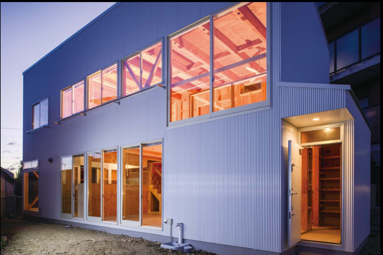
外壁仕上げは外断熱、通気工法の上ガルバリウム鋼板小波板張り
