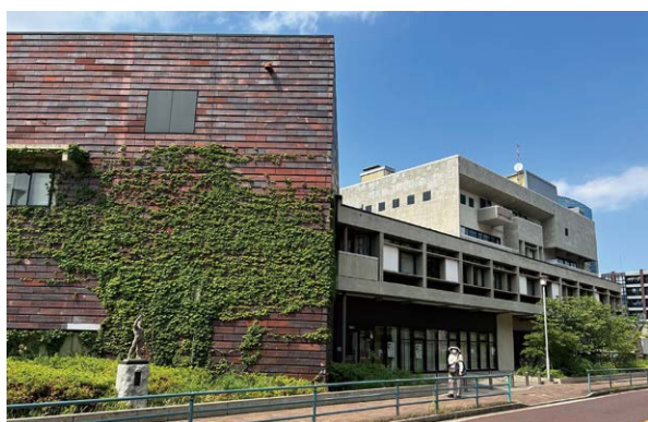
神奈川県青少年センター 南側から見た外観
