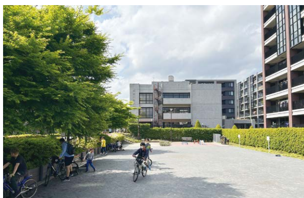
旧・神奈川県婦人会館 南側からの全景 手前の公園は青少年会館（一九六六年）の跡地
