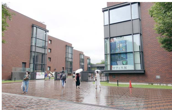
南側の正面アプローチからの全景。右側が改築された企画棟。
