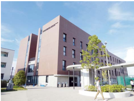
4階建RC造の校舎棟
