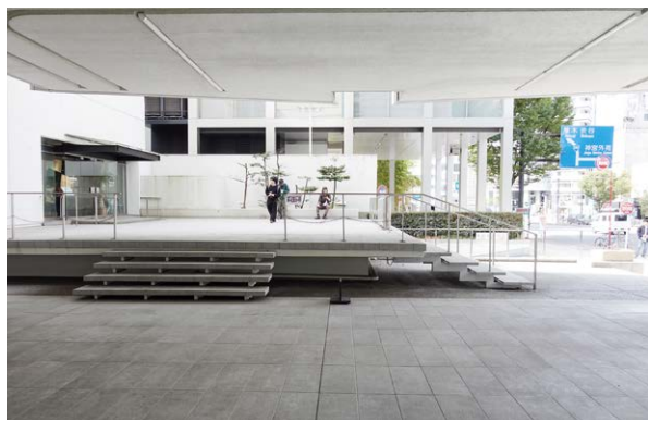
ピロティから見た西側のテラス
