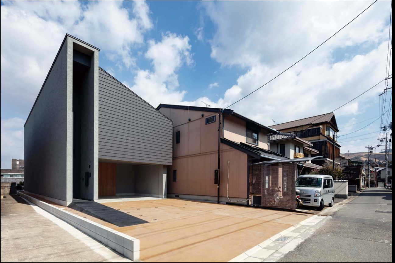
南側外観。外を引き込むスロープ。
