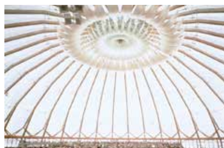
「出雲ドーム」(1992)。直径150m、高さ50m。32本の大断面集成材による張弦立体アーチはプッシュアップ工法で一気に立ち上がった。
