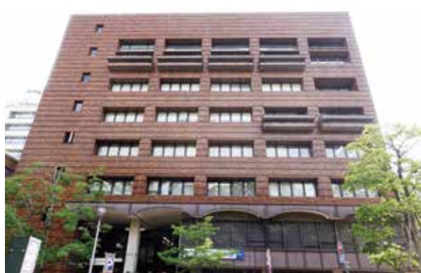
南西側から見る庁舎正面外観
