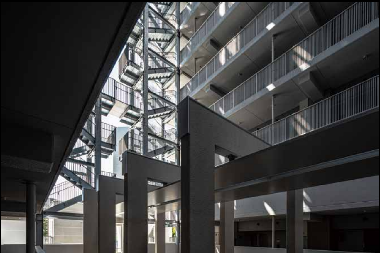
ツインコリドールで挟まれた中庭を貫くコロネードが印象的な空間を創る
