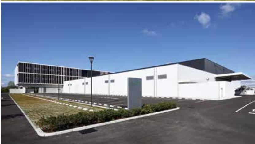
新型コロナワクチンの原薬製造と、パンデミック時に厚労省からの依頼に対応できる原薬製造の、2ラインプラントを最短期間で稼働させる建設プロジェクト。グローバルGMP・バイオハザード封じ込め基準に適合する明快なゾーニング・動線計画、信頼性の高い室圧・気流計画をエンジニアリング部門と共に計画した。製造棟は早期稼働を可能にする平屋建て・同一平面構成の製造空間とレイアウト変更や機器更新のフレキシビリティを高める建築・建築設備システム。事務棟は西側に広がる住宅地に対し、環境ならびに景観に配慮した建物構成・配置計画。西面の外気負荷を低減し室内環境を向上させるバルコニーと日射遮蔽ルーバーや、各管理部門をつなぐ3層吹抜のリフレッシュ空間：コミュニケーションポイドを構築し、従業員の快適性向上に寄与した。（KAJIMA DESIGN 近持真寛）
