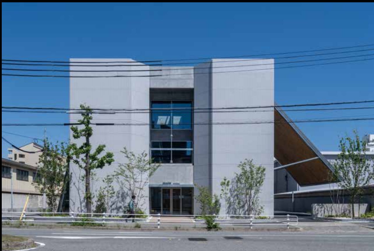
西側外観。既存建物から北側と南側に木と鉄骨を使って増築した大庇が跳ね出す。
