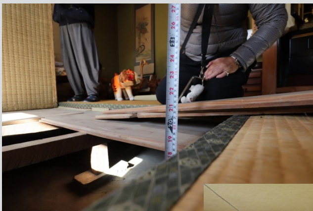
耐震診断：床下の調査
