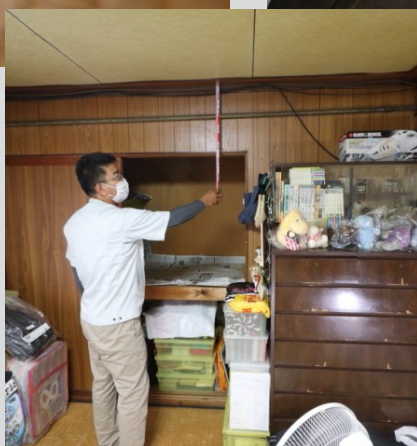
耐震診断：室内の調査
