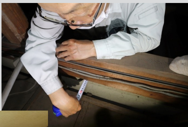
耐震診断：小屋裏からの調査
