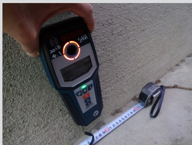
既存住宅状況調査における基礎鉄筋探査
