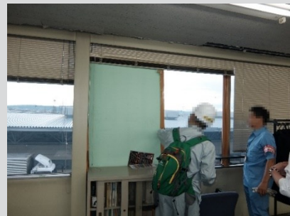
応急危険度判定調査状況
