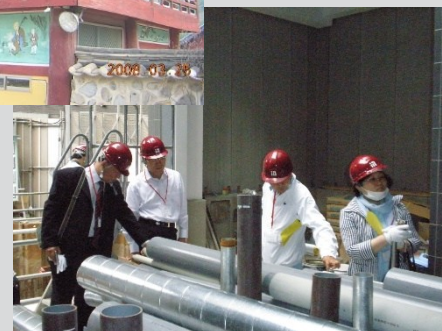
工事現場視察
