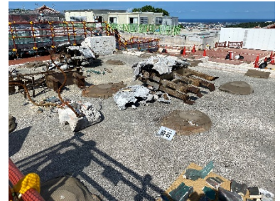
熱割れした火災後の首里城礎石
